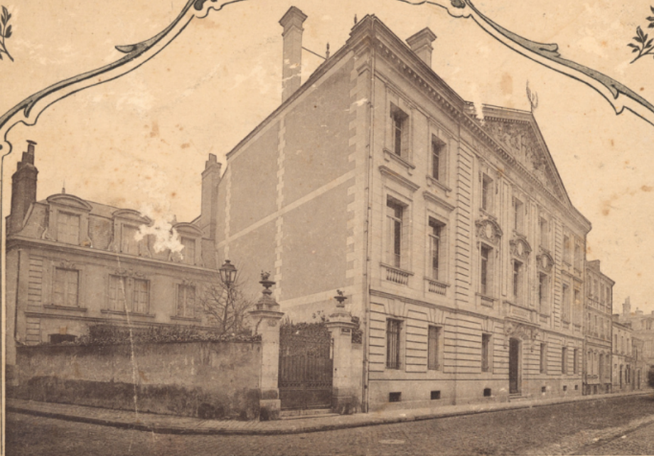
Vue générale du Lycée - Entrée de l'Externat
