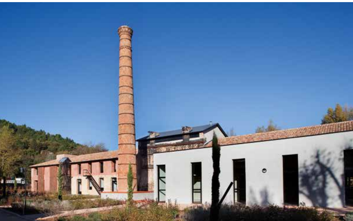
1 : Vue extérieure, cheminée en brique de l'ancienne fabrique.
