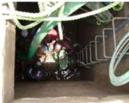
Tchad, Abéché, Réparation d’une canalisation d’eau, 2011.
