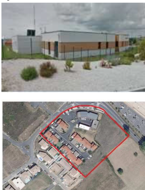
Figure 1 : Vues de la construction
