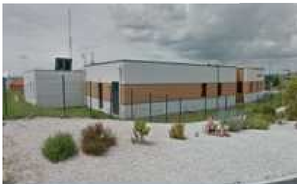
Figure 1 : Vues de la construction
