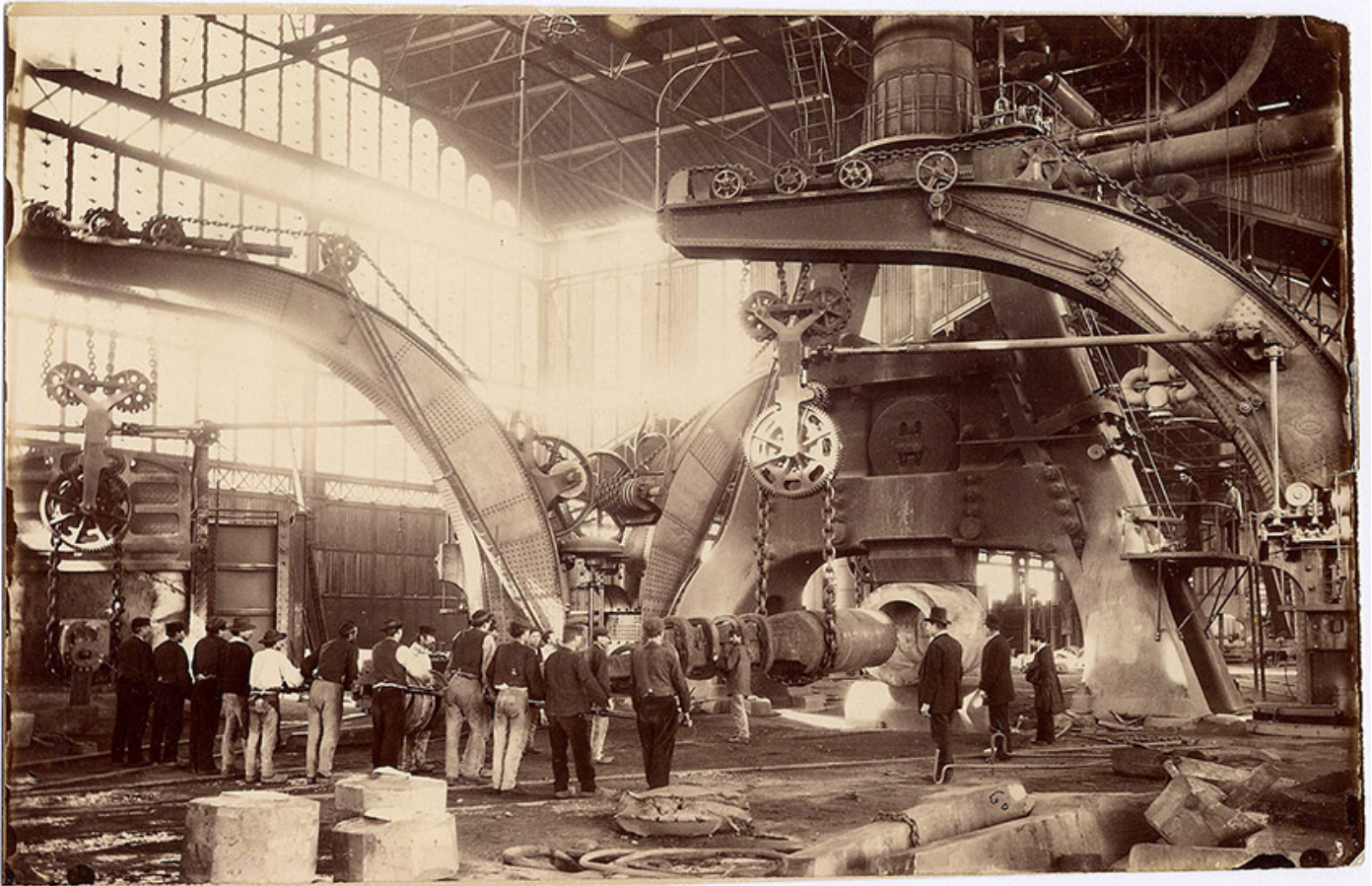
Établissements Schneider et Cie (Le Creusot) : photo de « l'Album 1881 ». Intérieur d'un atelier de Grosse Forge : la halle du marteau-pilon de 100 tonnes.
