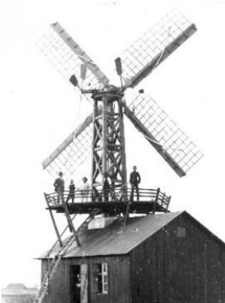
Poul La Cour, première éolienne électrique du Danemark, 1891. Source : https://www.poullacour.dk/en/gallery-histor.jpg?id=histoire_energie_eolienne ,
