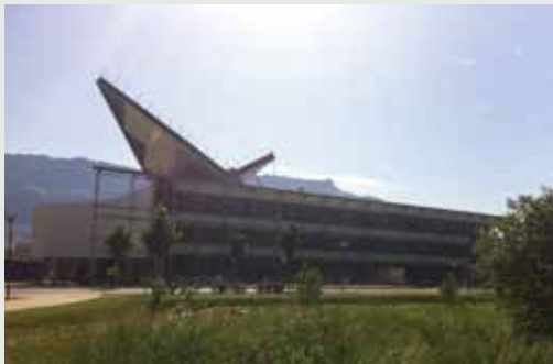
Fig 10 La construction du nouveau siège de l'INES : Hélios
